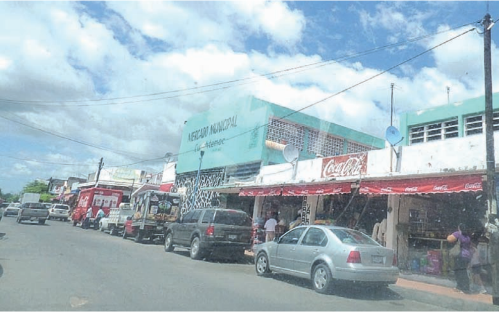
Foto Internet La Secretaría de Infraestructura y Desarrollo Urbano estudiará la situación en la que se encuentra el Mercado Cuauhtémoc, para determinar las etapas de remodelación.
