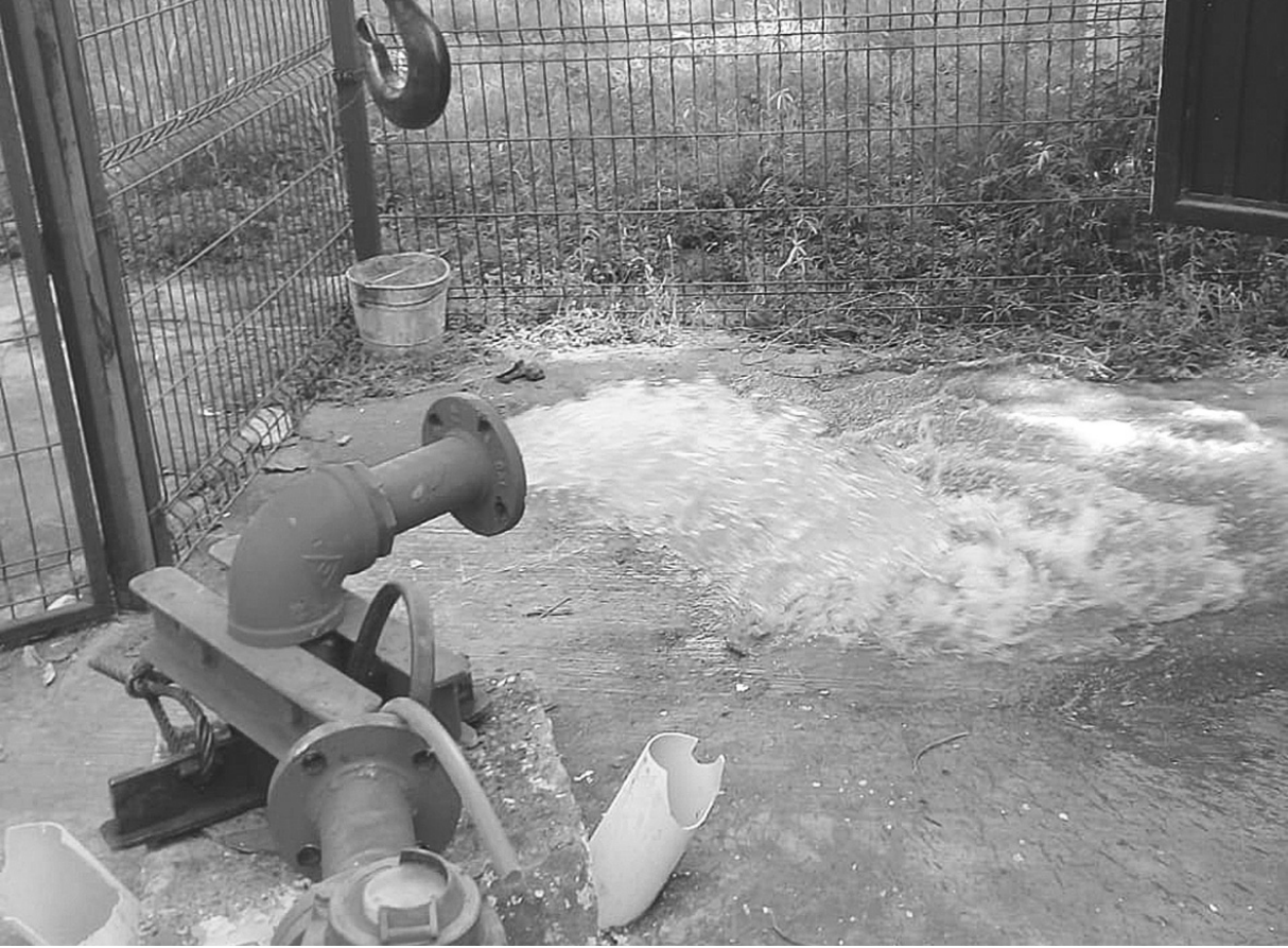
Foto Agencia Luego de varios días sin servicio de agua potable, la comunidad de Los Limones, en Coquimatlán, volvió a tenerlo, tras la reparación del motor de la bomba abastecedora.
