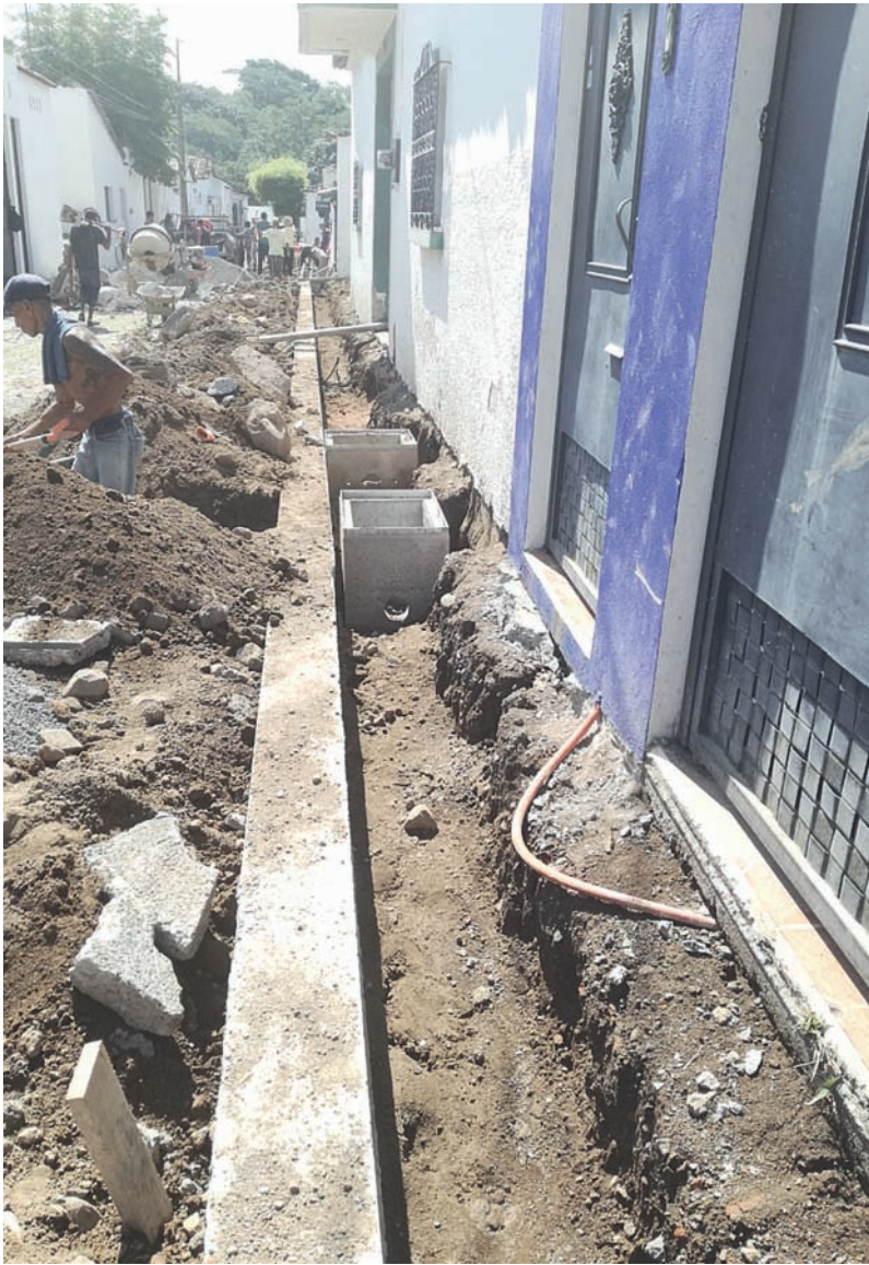
Foto de Carlos Lemus El Gobierno del Estado trabaja en la primera etapa del cableado subterráneo en la zona de monumentos históricos de Comala.
