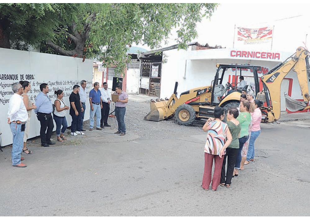
Foto de Juvenal Martínez En Armería pusieron en marcha obras de rehabilitación de las redes de agua potable y drenaje, con una inversión de un millón 294 mil pesos.
