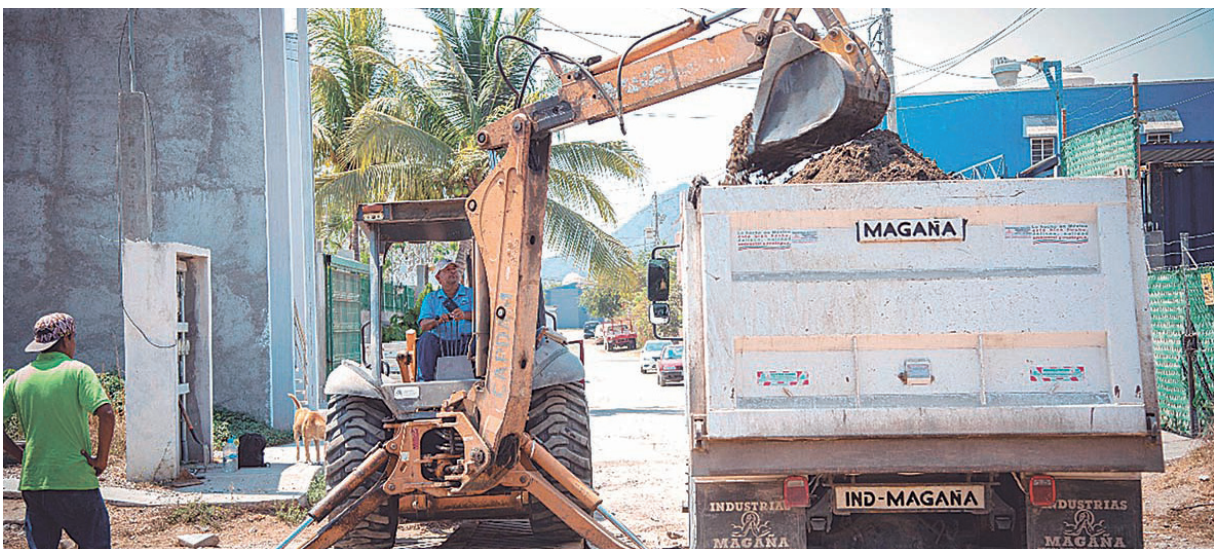
Personal de la CAPDAM redobla acciones de desazolve en la red de alcantarillado previo a las lluvias.
