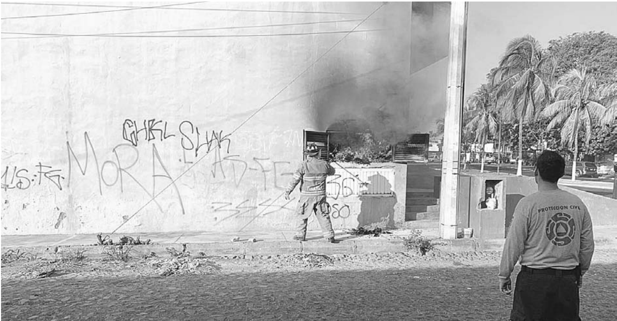
Foto de Sergio Uribe Un cortocircuito en el transformador de una tienda de conveniencia ocasionó un conato de incendio, ayer por la tarde, en el cruce de la avenida Niños Héroes y Calzada del Campesino.
