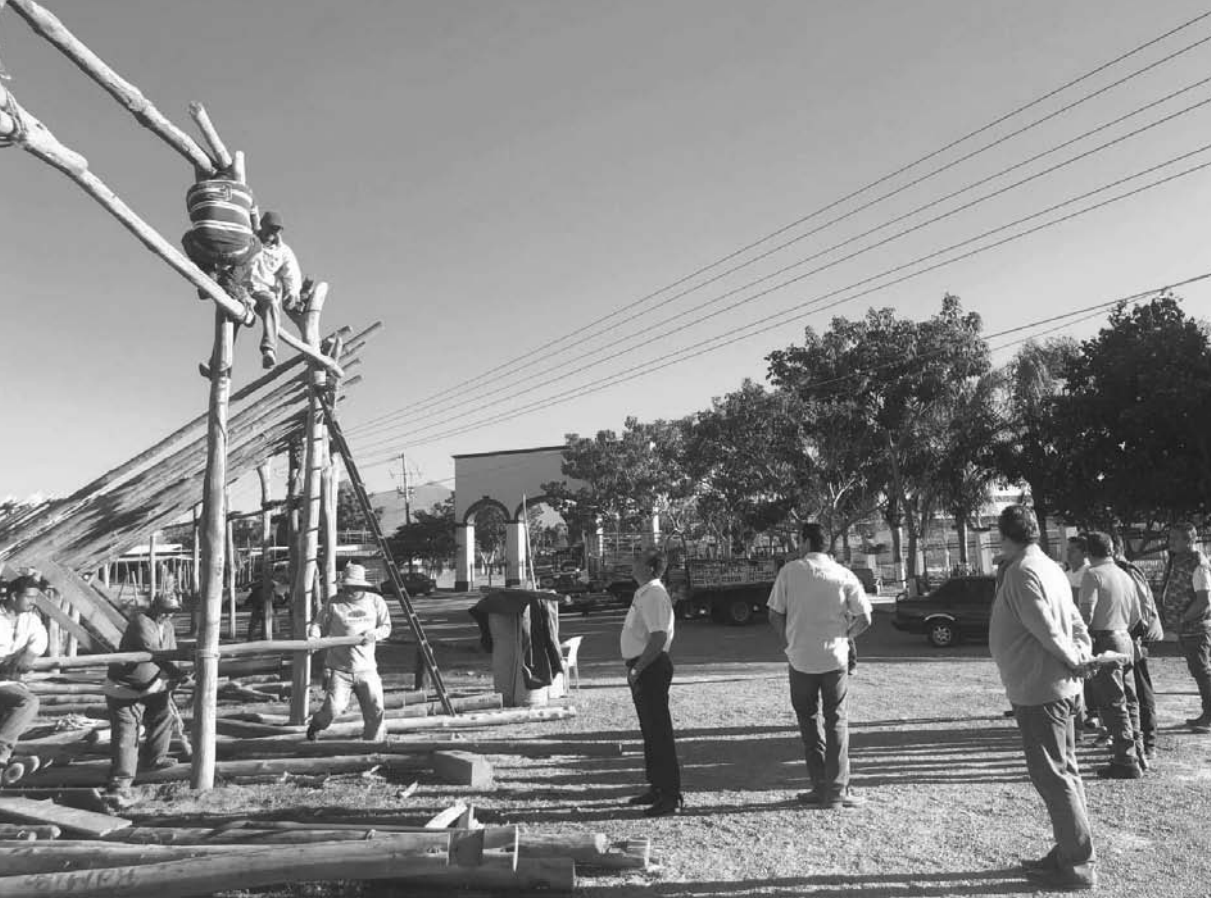
Foto de Carlos Lemus Acompañado por funcionarios municipales, el alcalde de Villa de Álvarez, Felipe Cruz, supervisó las instalaciones de la Feria y el avance en la construcción de La Monumental Plaza de Toros La Petatera.
