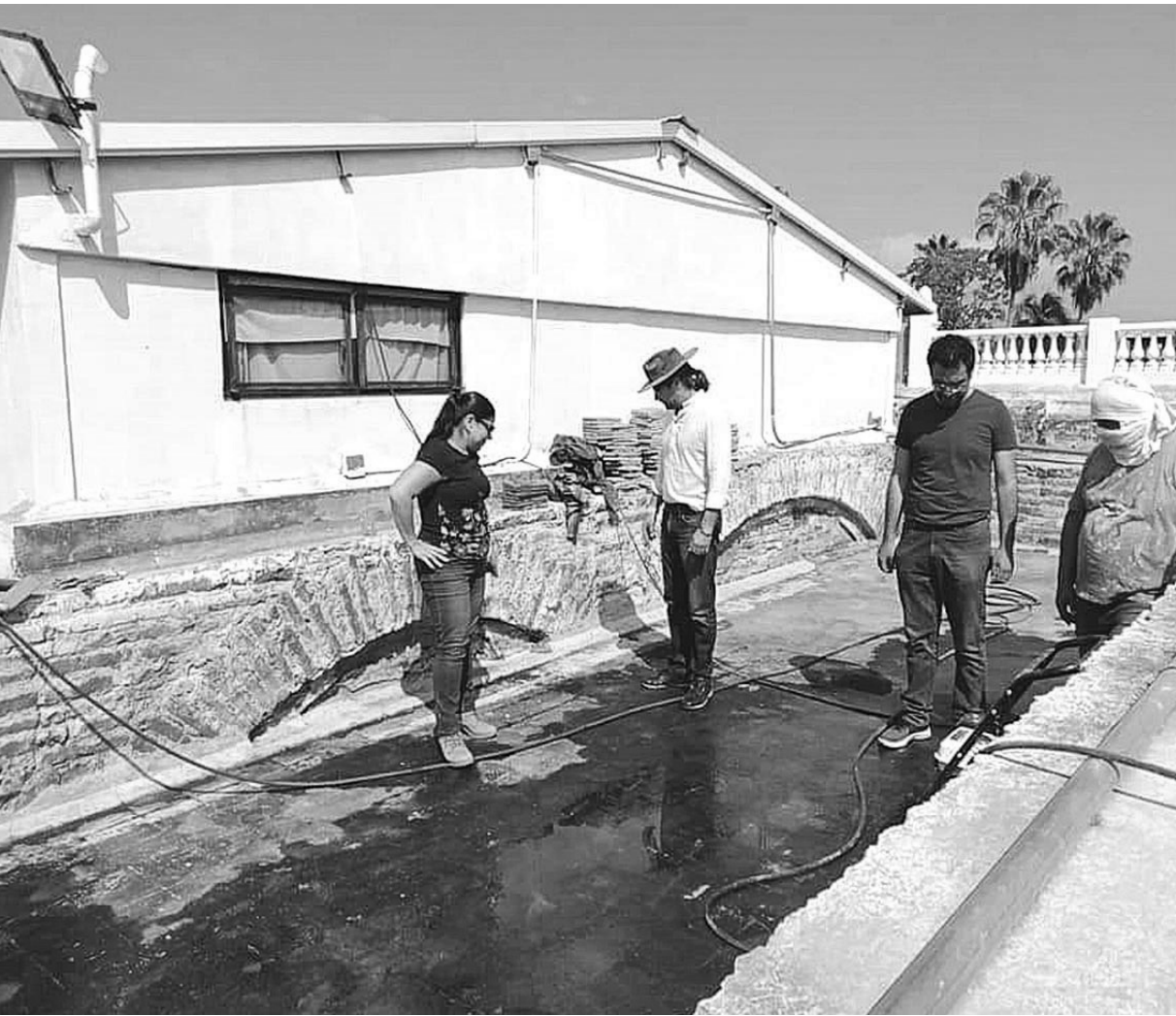
Foto cortesía del Museo Regional de Historia La arquitecta del INAH, Cynthia Polanco Isais, en compañía del director del Museo Regional de Historia, Fernando Rodríguez García, supervisan los trabajos de restauración en el techo del recinto.
