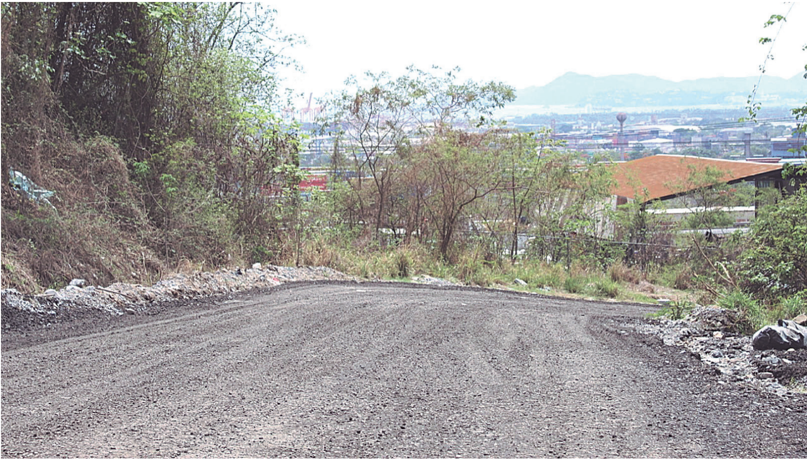
Foto de Osiris Moreno Gracias al asfalto reciclado que gestionó el Ayuntamiento de Manzanillo, luce en mejores condiciones la entrada al relleno sanitario, lo que permitirá mejorar el acceso, aun durante el periodo de lluvias.
