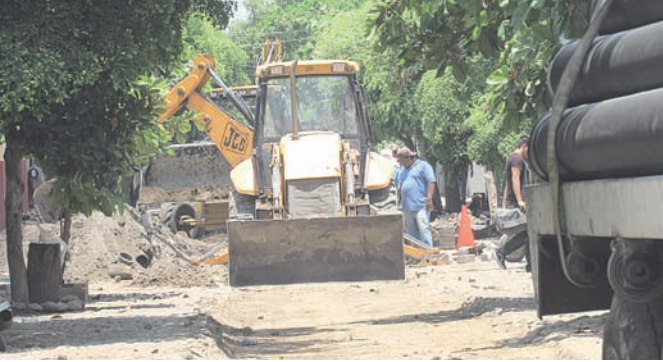
Juvenal Martínez El Ayuntamiento de Armería rehabilita la red de drenaje de la calle Puebla, ya que en algunos puntos empezaban a emanar aguas negras.
