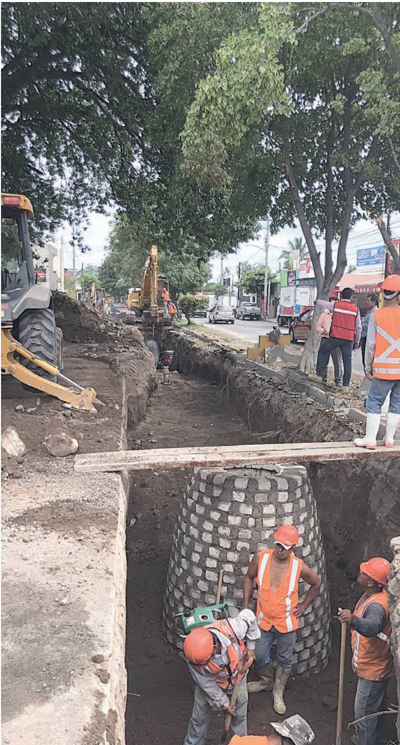
Foto Agencia Buen avance llevan los colectores pluviales que construye el Ayuntamiento de Villa de Álvarez.
