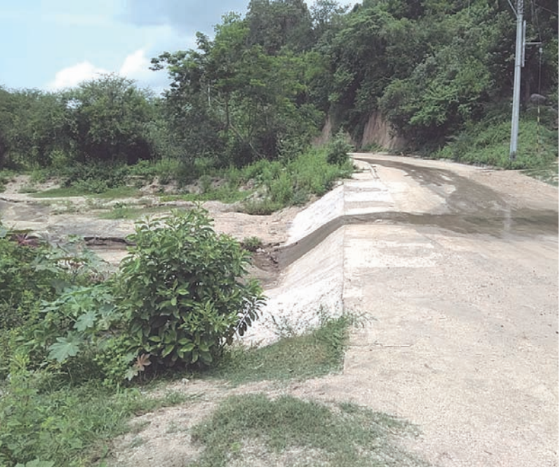
Antes de que se colapsara la calle, fue reparado el vado del arroyo de Chandiablo, fracturado por las lluvias de la temporada pasada.
