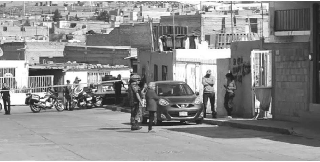
Foto Internet En una casa ubicada en la calle Sierra de Mil Cumbres, en la capital de Aguascalientes, detonó un artefacto explosivo dañando varias viviendas.
