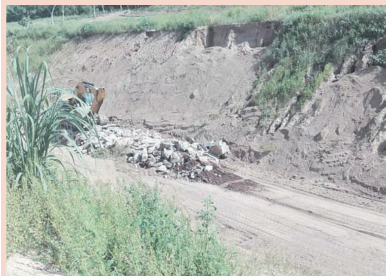
Con maquinaria de la Conagua se coloca piedra sobre el cauce del río Marabasco, para construir muros de contención y evitar desbordamientos.
