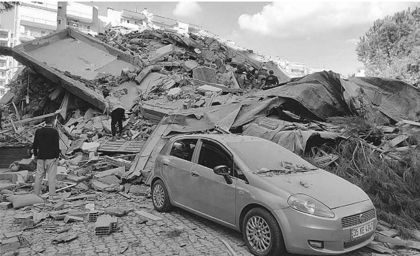
Un terremoto sacudió ayer la isla griega de Samos, en el este de Grecia, y la costa egea de Turquía, registrándose cuantiosos daños materiales.
