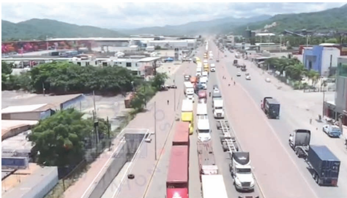
Foto drone de la UTCM
