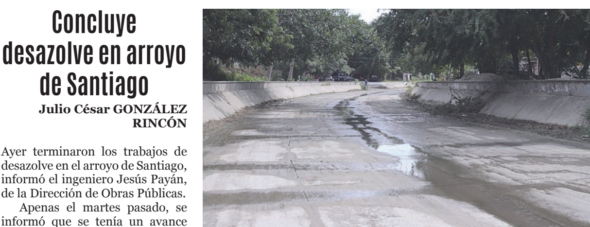
Foto de Julio González El Ayuntamiento de Manzanillo concluyó el desazolve del arroyo de Santiago, el cual durante la temporada de secas es utilizado como vía alterna.
