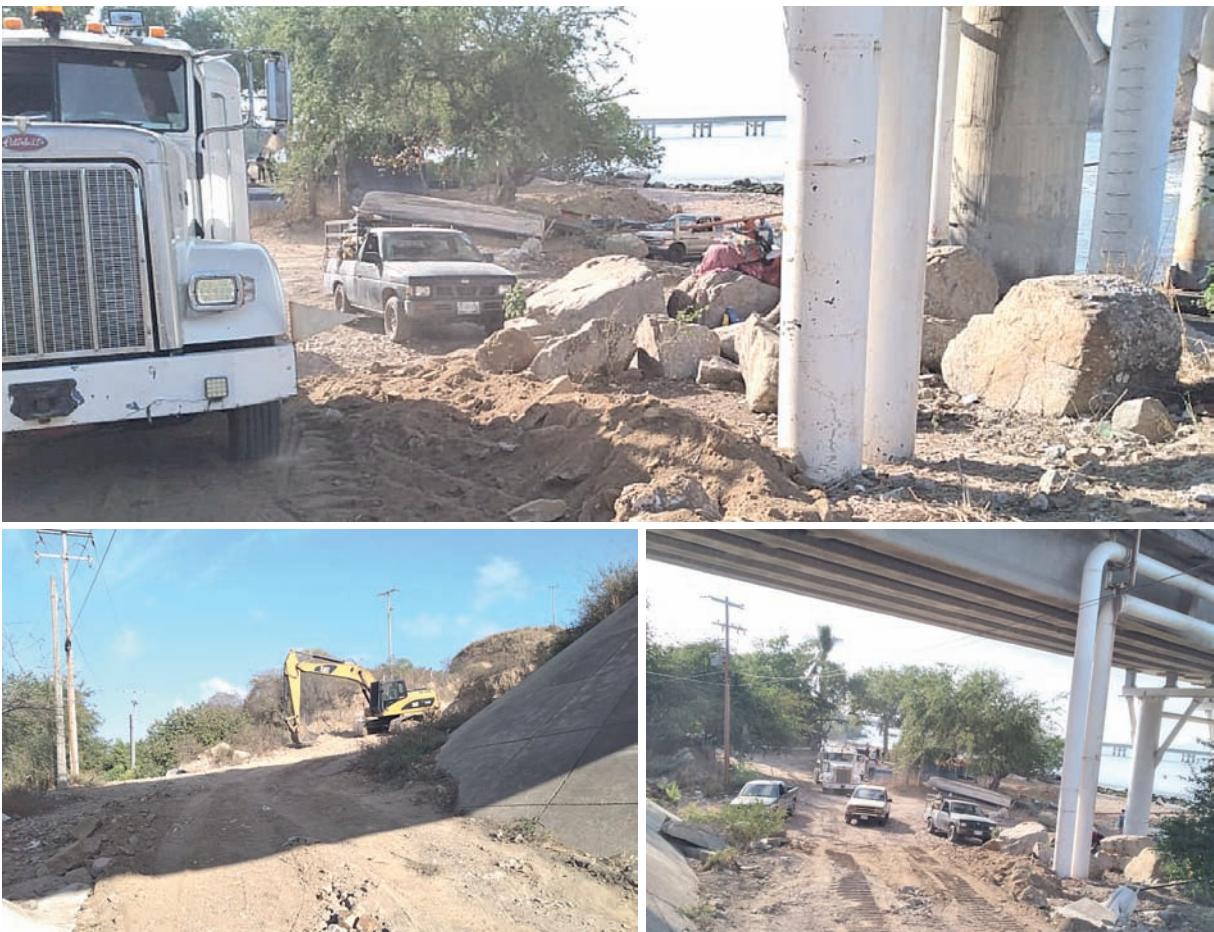
Fotos de Julio César González La concesionaria de la autopista Manzanillo-Colima, Pinfra, inició trabajos de restauración en el puente Tepalcates, pero pescadores aseguran que no cuenta con permisos para hacerlos.
