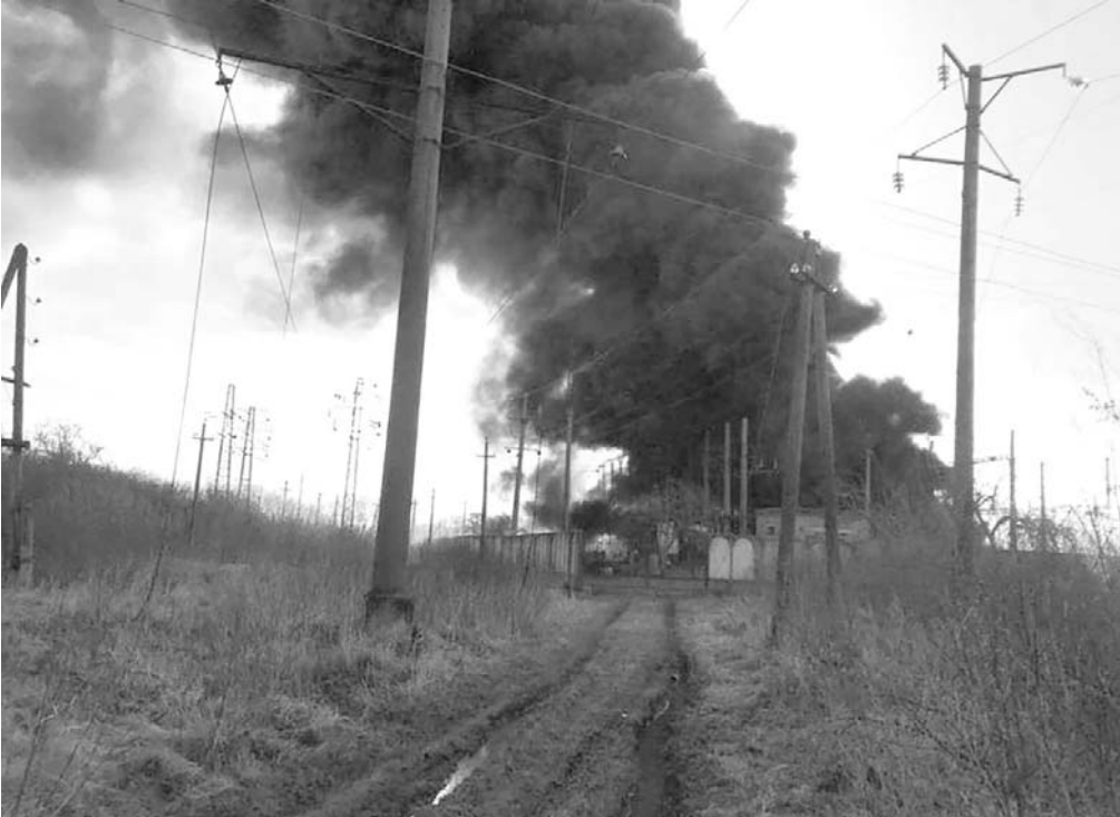
Foto Internet Explosión en la subestación de tracción de la estación de tren de Krasne, como resultado de un ataque con misiles.
