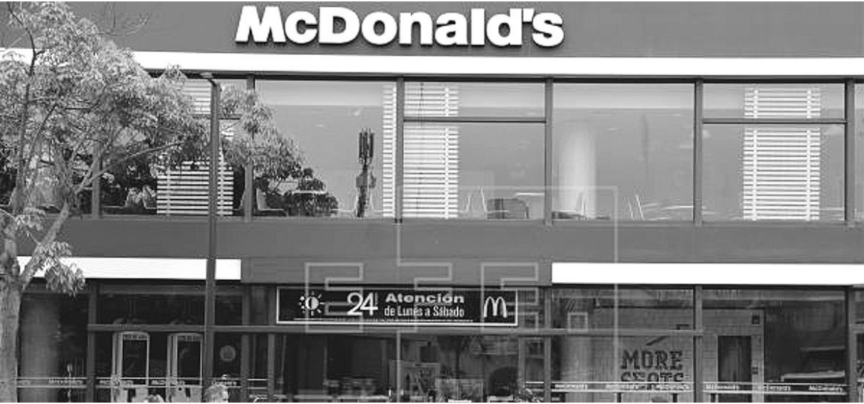
Foto Internet Dan a conocer peritos de la Policía Nacional del Perú, que la causa de la muerte de los dos jóvenes trabajadores de McDonald's debió a una descarga eléctrica.
