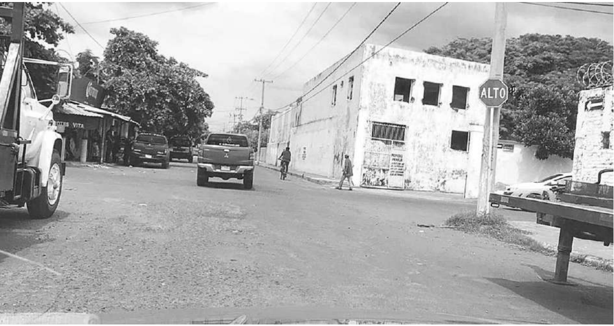
En el edificio de la antigua cárcel municipal, en la calle Javier Mina del centro de Tecomán, fueron encontrados los restos humanos de una persona.
