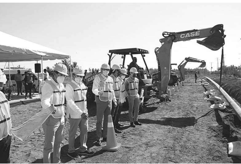
Foto Coordinación de Prensa de Gobierno del Estado El gobernador José Ignacio Peralta Sánchez, en gira de trabajo por Tecomán, presidió el inicio de obra de la Línea de Distribución de Gas Natural por parte de la empresa Gas Natural Noroeste.
