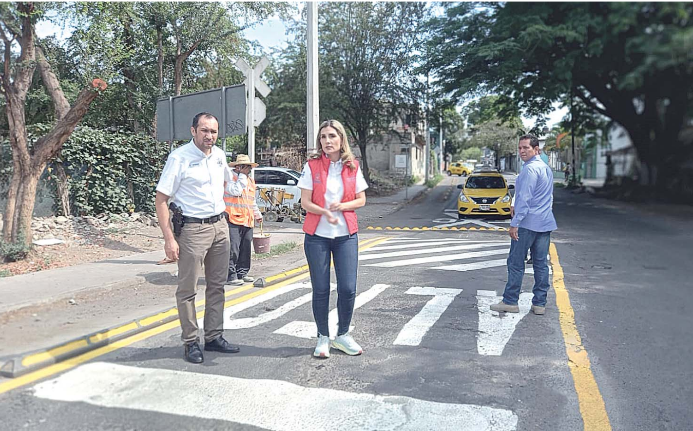
La alcaldesa de Colima, Margarita Moreno, supervisó los trabajos de señalización a la entrada de la colonia Mirador de la Cumbre, para tratar de prevenir accidentes por el paso del tren.
