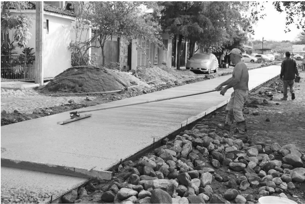
Foto Ayuntamiento de Villa de Álvarez El alcalde Felipe Cruz puso en marcha un nuevo paquete de 17 obras en la zona urbana y rural de Villa de Álvarez.
