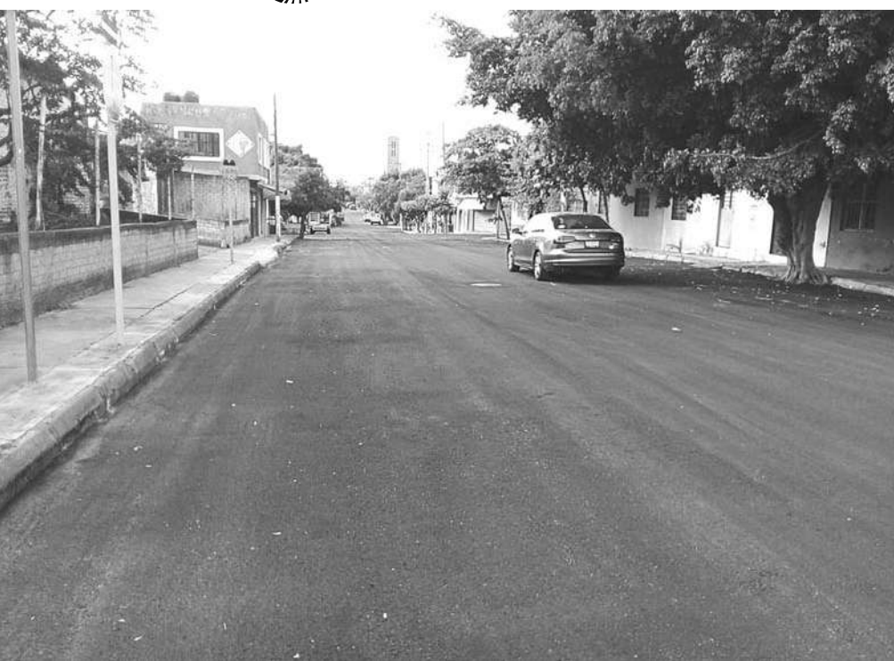
Foto de Alberto Medina Aspecto de la repavimentación que realizó el Ayuntamiento de Colima en la avenida Madero, en la colonia de Los Trabajadores, al oriente de la ciudad.
