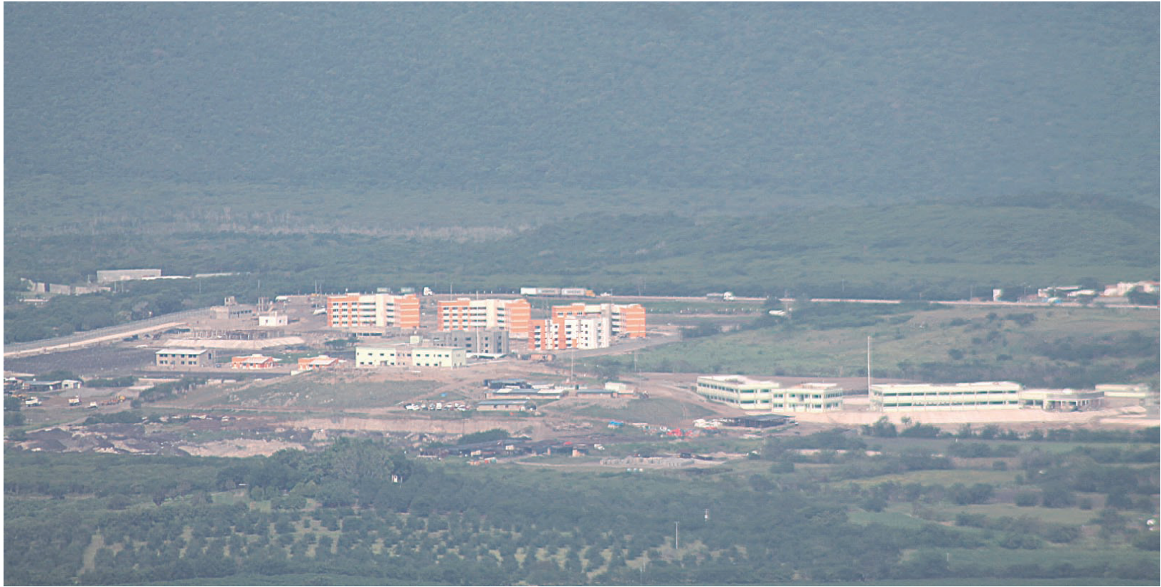
Foto de Armando Martínez de la Rosa Las obras de las nuevas instalaciones de la 20ª Zona Militar, en Loma de Fátima, registran 80 por ciento de avance. La imagen fue tomada desde la cima del cerro de La Cumbre.
