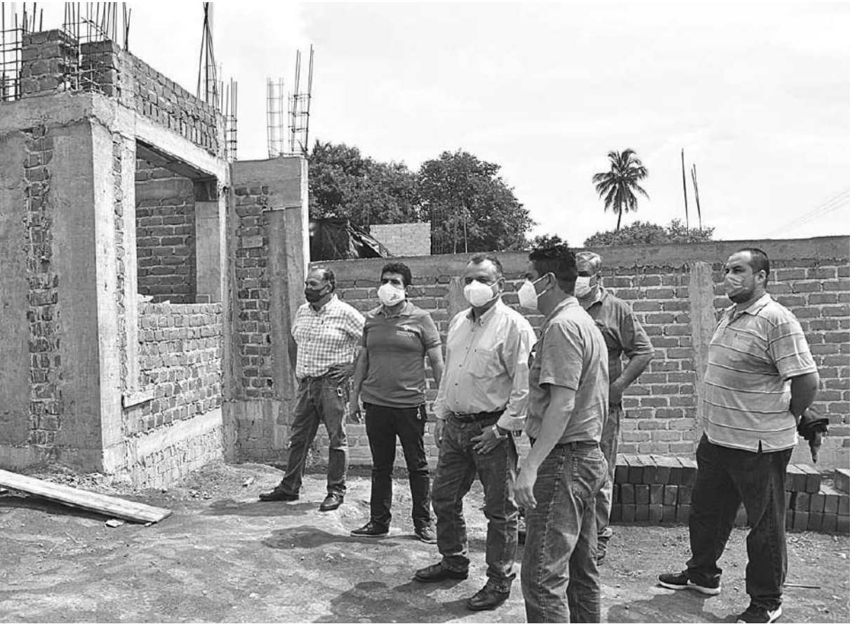
Foto Ayuntamiento de Villa de Álvarez Al visitar las instalaciones en proceso de una empresa comercial que generará 525 empleos en la Villa, el alcalde Felipe Cruz refrendó su disposición para brindar las facilidades correspondientes.
