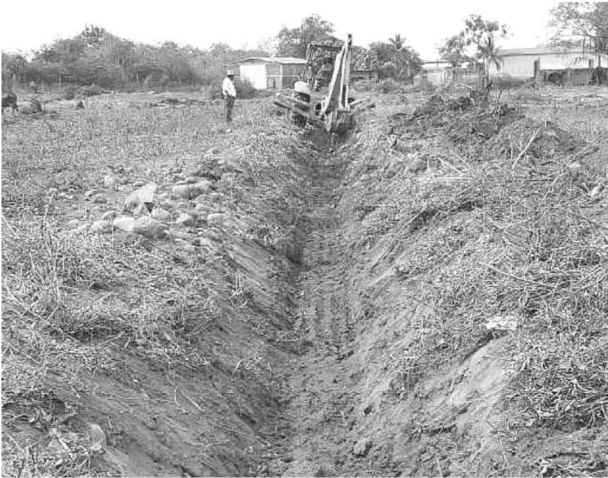
Foto de Juvenal Martínez La encargada del Despacho de la Dirección de Obras Públicas y Desarrollo Urbano, María de los Ángeles Cruz, informó que continúan trabajando en el desazolve de drenes en distintos puntos de Tecomán.
