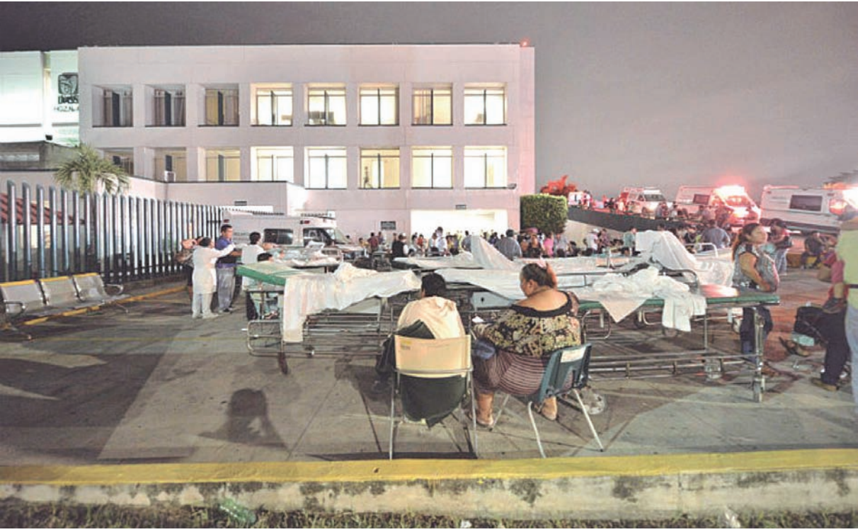
Cuerpos de auxilio confirmaron que se colapsó una parte del techo del hospital regional de La Piedad, Michoacán, por lo que tuvieron que evacuar a algunos pacientes.
