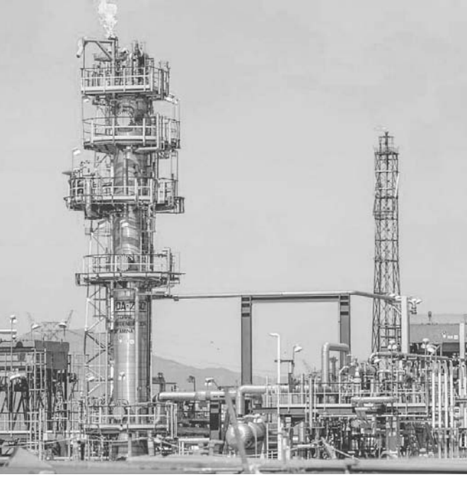
Foto Internet La Sener declaró desierta la licitación para construir la refinería de Dos Bocas, Tabasco.
