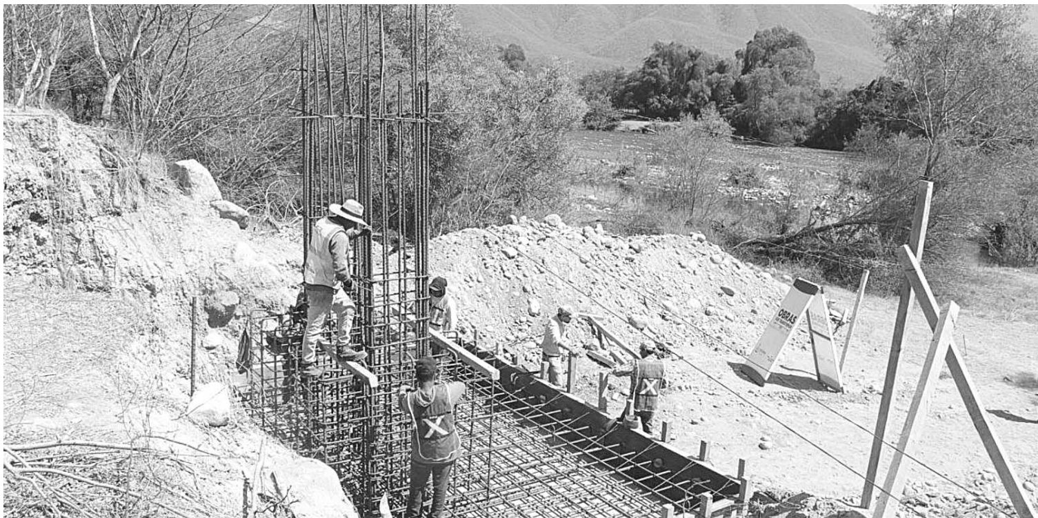
El puente colgante que se construye en la comunidad de Las Conchas, Ixtlahuacán, beneficiará a 485 habitantes de esta localidad, y a 70 ejidatarias y ejidatarios, señaló Marisol Neri León, titular de la Secretaría de Infraestructura, Desarrollo Urbano y Movilidad.
