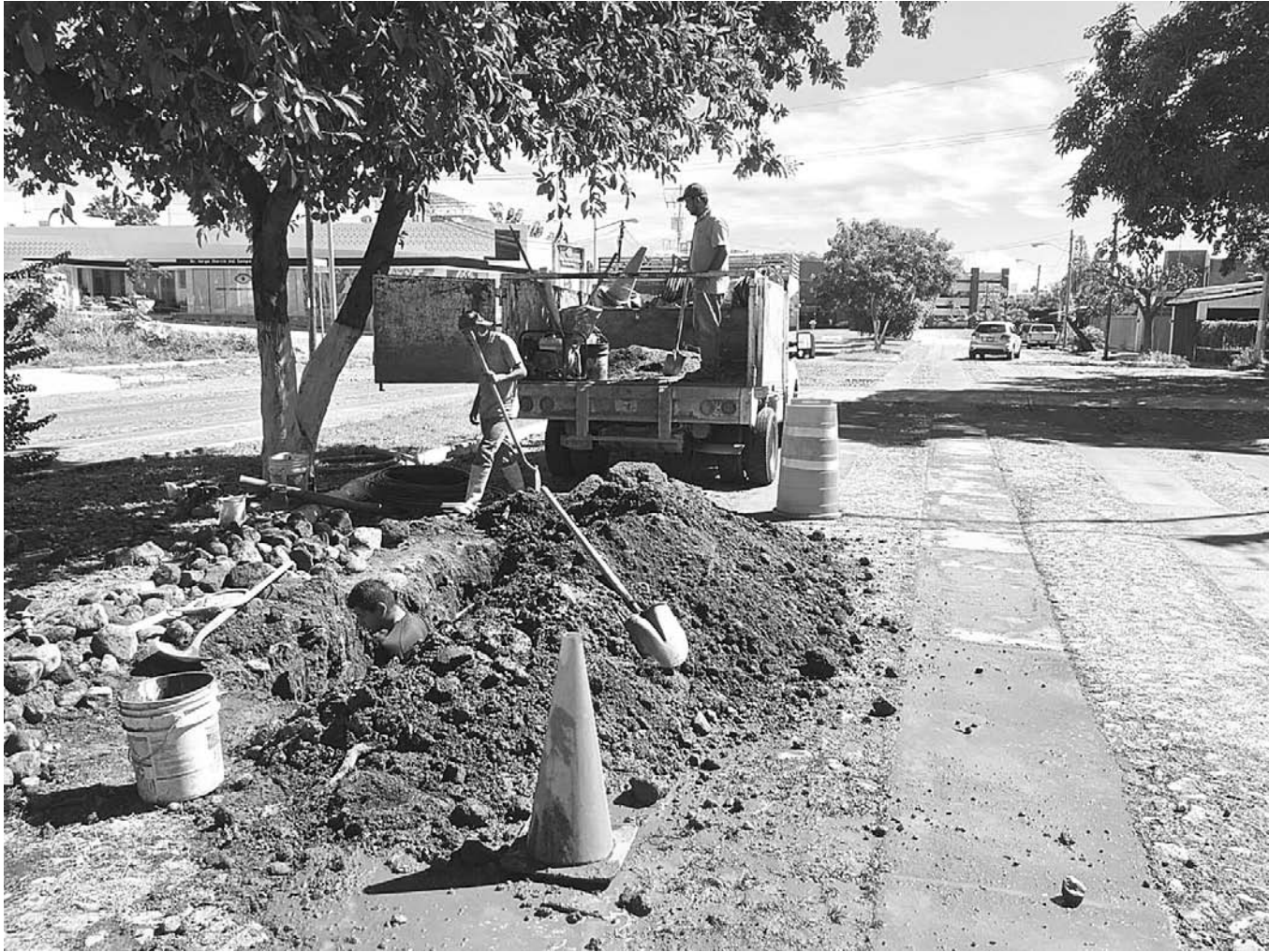
Foto de Hugo Ramírez Trabajadores de la Ciapacov repararon una fuga de agua que se registró en el sistema hidráulico sobre avenida La Paz, la cual se originó, debido a que la raíz de un árbol venció un conector del vital líquido.
