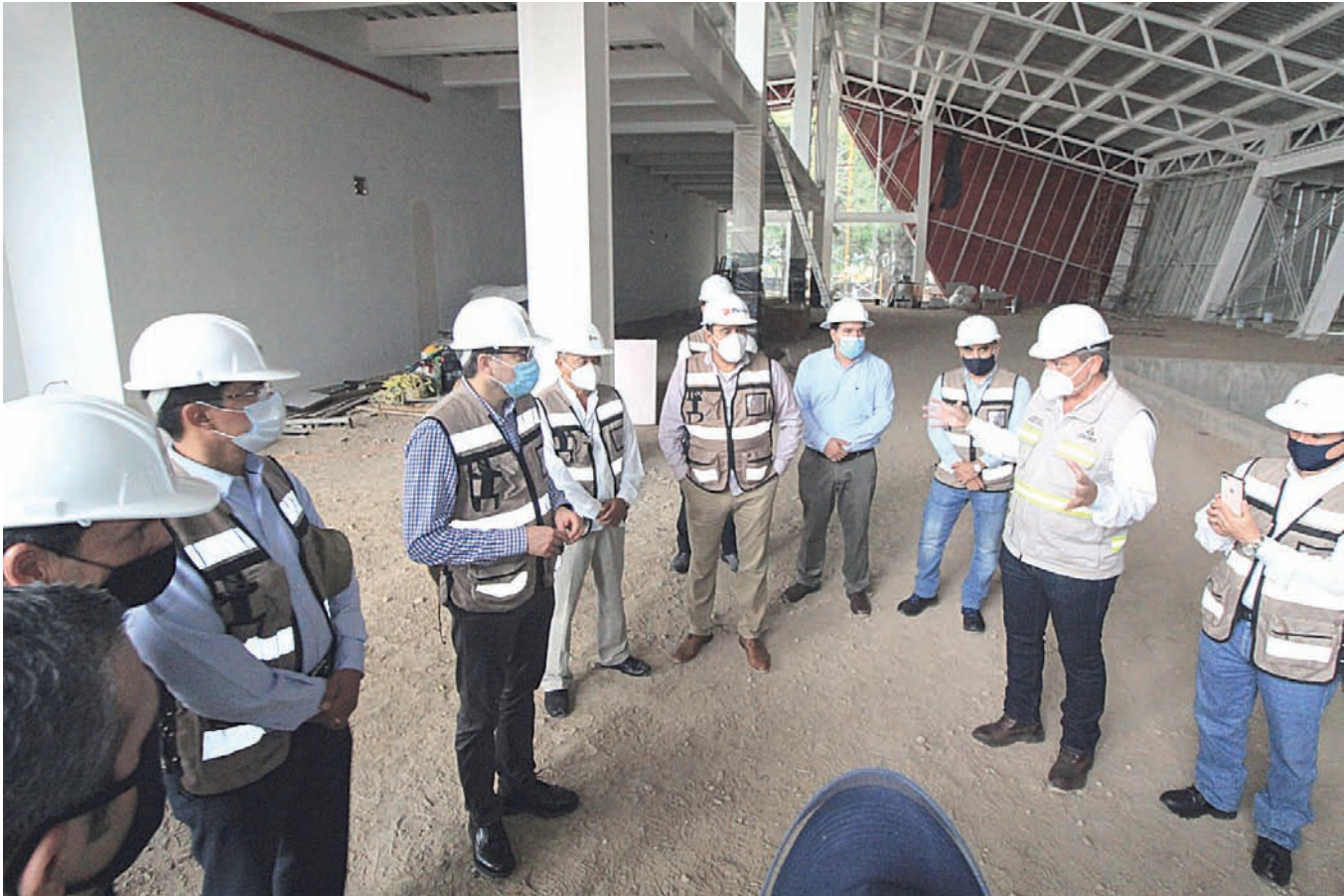
Foto Coordinación de Prensa de Gobierno del Estado Acompañado por funcionarios de su Gabinete, del alcalde de Colima, Leoncio Morán Sánchez, y de Diputados locales, el gobernador José Ignacio Peralta Sánchez recorrió la obra de construcción del C5i.
