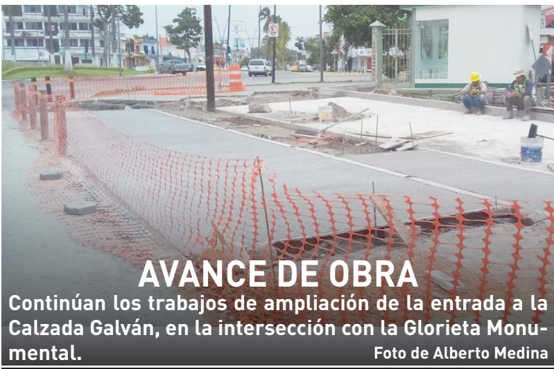
AVANCE DE OBRA
