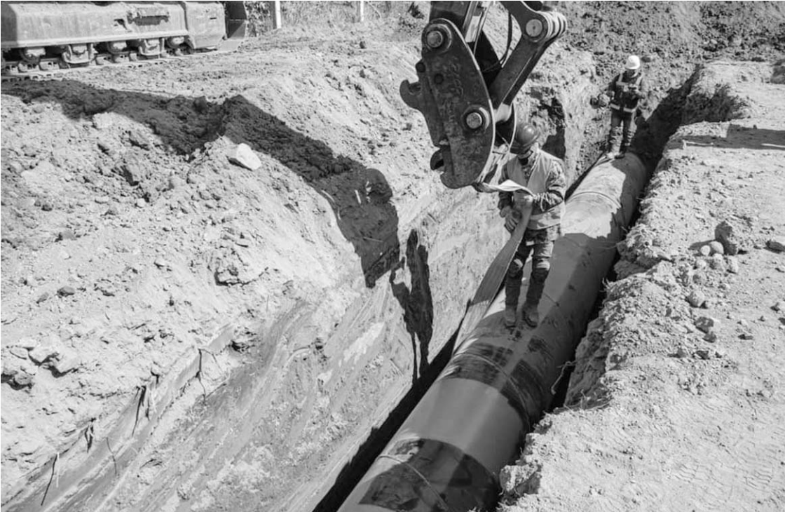
Más de 837 millones de pesos invierte la Asipona Manzanillo en la construcción del nuevo acueducto Armería-Manzanillo.
