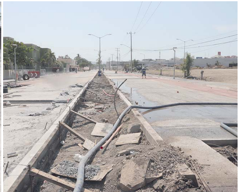
Fotos Ayuntamiento de Manzanillo
