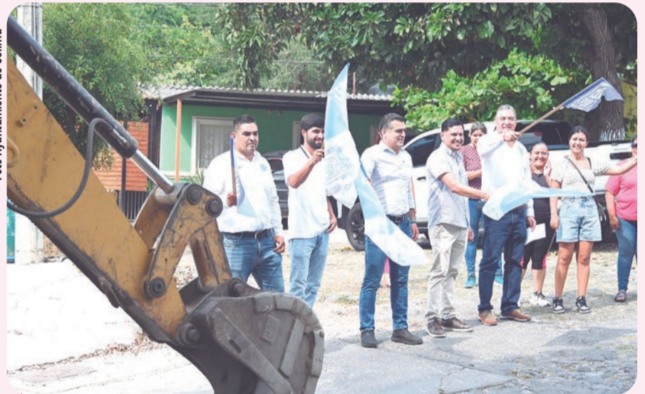
Una de las obras fue la introducción del drenaje en la calle principal de El Chanal.
