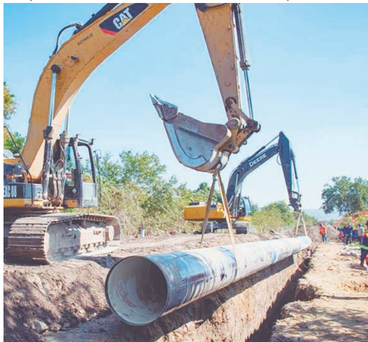
La obra del Acueducto Armería-Manzanillo, beneficiará a cientos de miles de familias, pues resolverá el abasto de agua a los manzanillenses por más de medio siglo.
