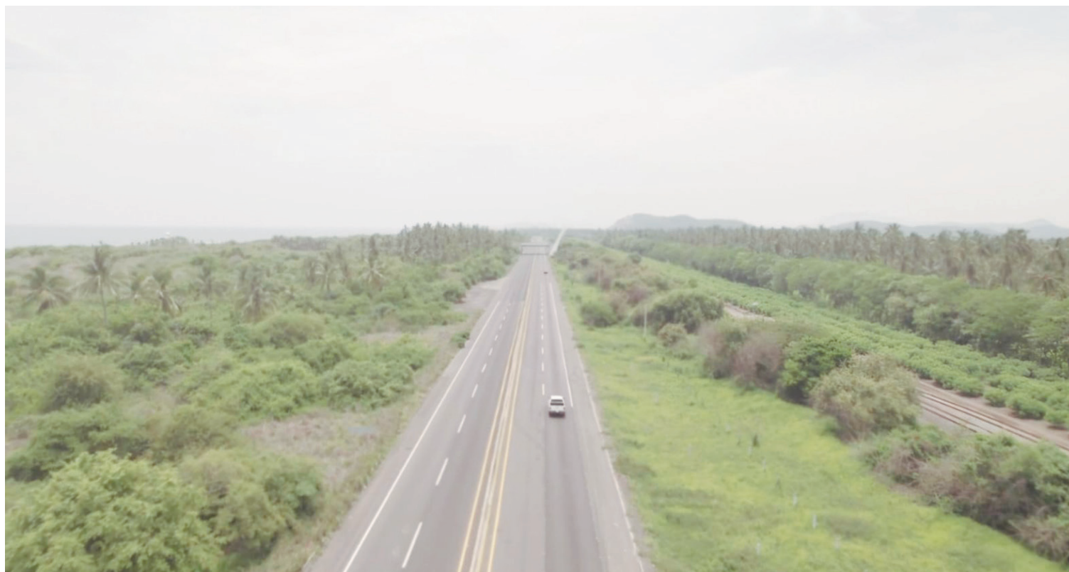
La ampliación de la carretera Armería-Manzanillo, contribuirá al imparable desarrollo del puerto de Manzanillo.
