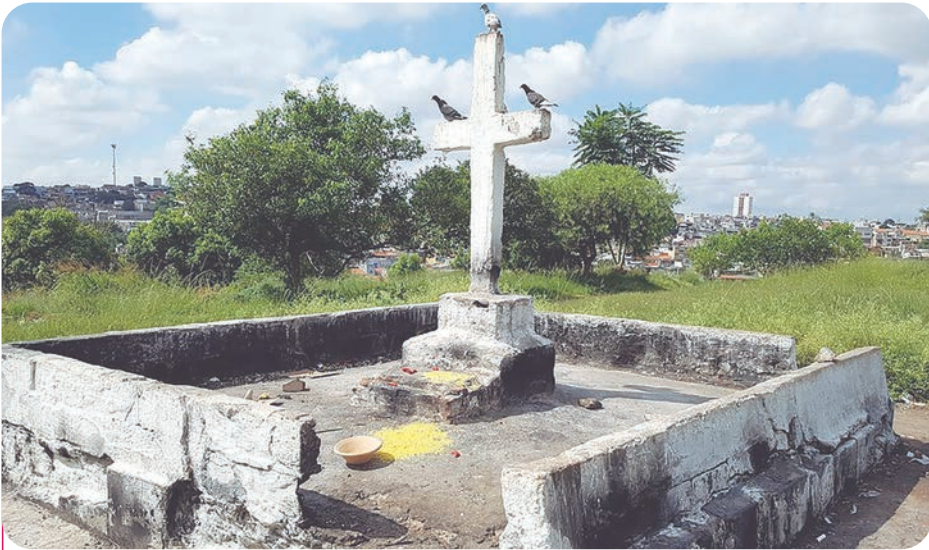
El camino al camposanto está en malas condiciones estado y dificulta el acceso de las familias.
