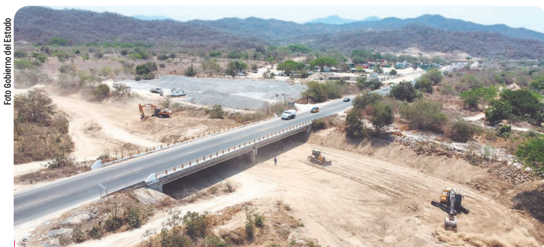
Uno de los trabajos que están en proceso es el desazolve del Arroyo Punta de Agua.
