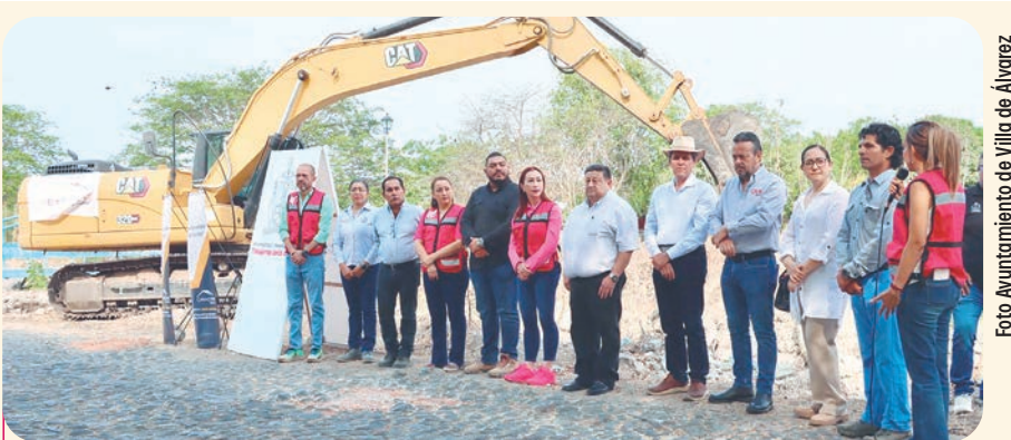
En el arranque de obra, la alcaldesa sostuvo que sólo trabajando en equipo es como se puede atender a la población de una manera más eficiente.
