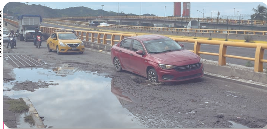
Aspecto de la lateral que está sobre el bulevar Miguel de la Madrid, en el sentido Manzanillo Centro-Brisas, a la altura de la zona industrial.
