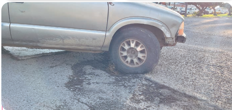
En las imágenes se muestran baches que están ubicados en el boulevard Carlos de la Madrid Béjar, avenida 20 de Noviembre, centro de la capital, Anastasio Brizuela y avenidas Constitución y San Fernando
