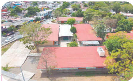
La gobernadora Indira Vizcaíno presidió la entrega de estas obras en ambos planteles escolares.
