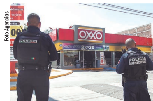
Tienda Oxxo dañada en San Francisco del Rincón, Guanajuato.
