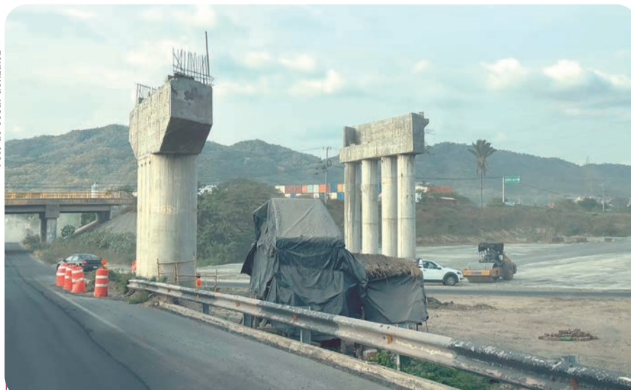
Ya inició la construcción del distribuidor del entronque a Jalipa.
