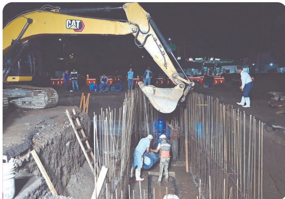
Ciapacov dio a conocer que luego de más de 80 horas de trabajo ininterrumpido, el sábado concluyeron los trabajos de reubicación del Acueducto Zacualpan.
