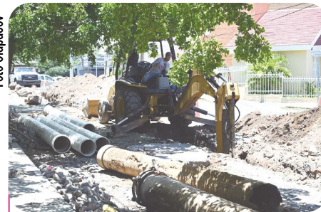
Los trabajos consistieron en la sustitución de 30 metros de línea de conducción de agua potable de 14 pulgadas sobre la calle Miguel Hidalgo, en la colonia La Cajita de Agua, de VdeA.
