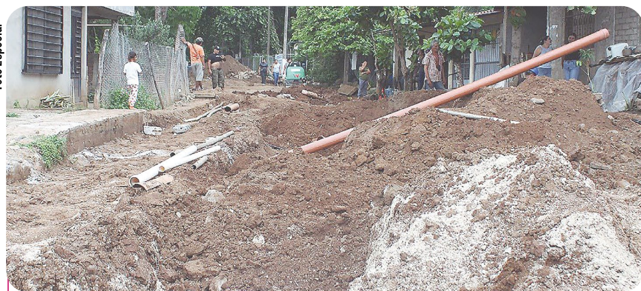
Una de las obras es la rehabilitación integral de la calle El Rebozo, en La Presa.
