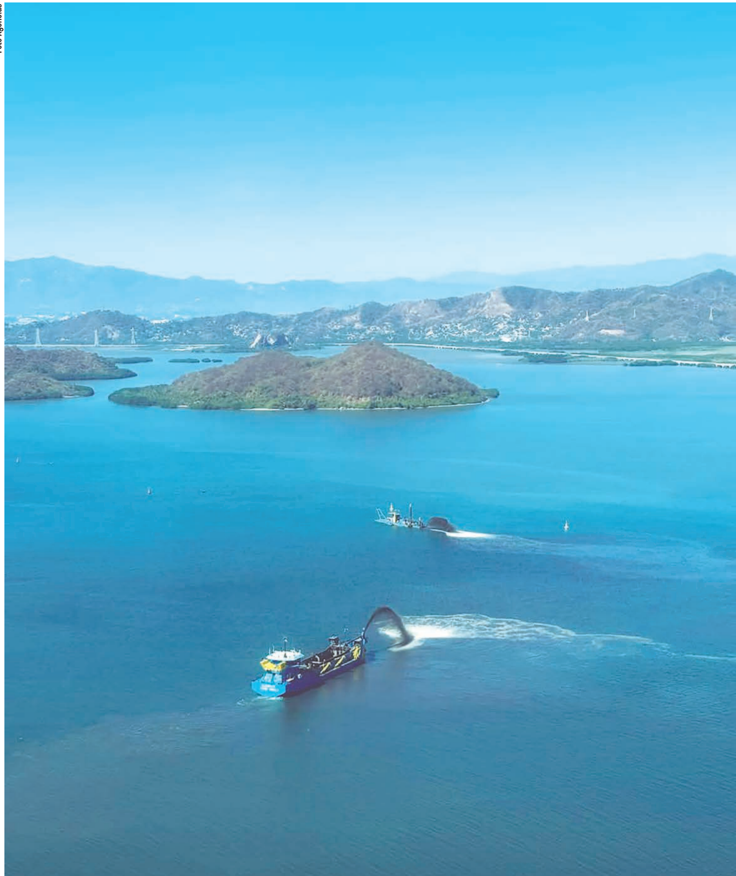
La primera etapa de Puerto Cuyutlán ha arrancado formalmente con el inicio de operaciones de dragado con dos de seis dragas.
