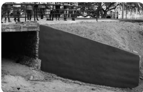
Muro de contención
