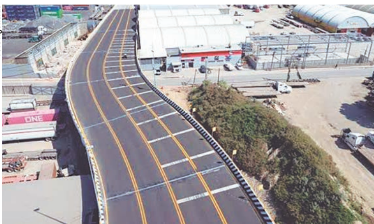
Indiscutiblemente la obra del II Acceso fue un acierto y ya se aprecian los resultados, a 3 meses de su inauguración.
