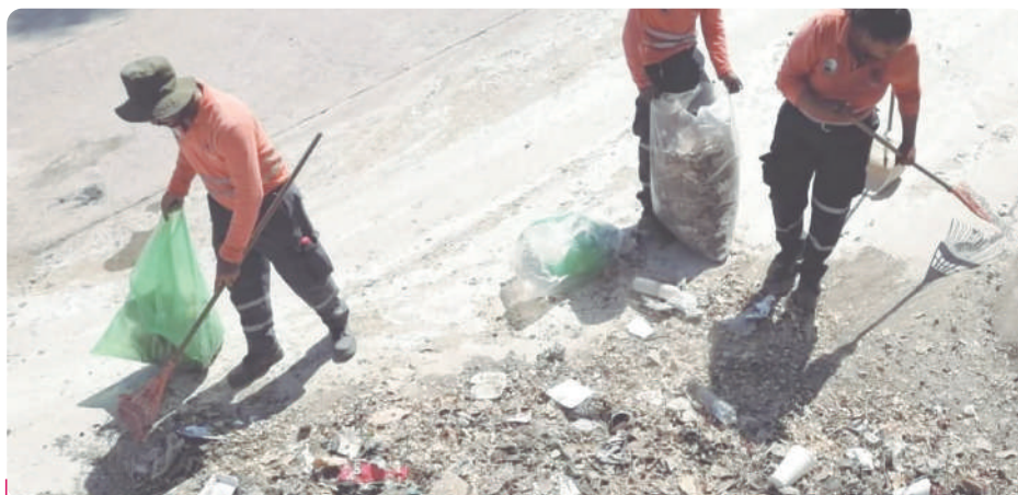
Durante las lluvias recientes, se retiró más de una tonelada de basura en drenes y alcantarillas de las colonias vecinas del puerto.
