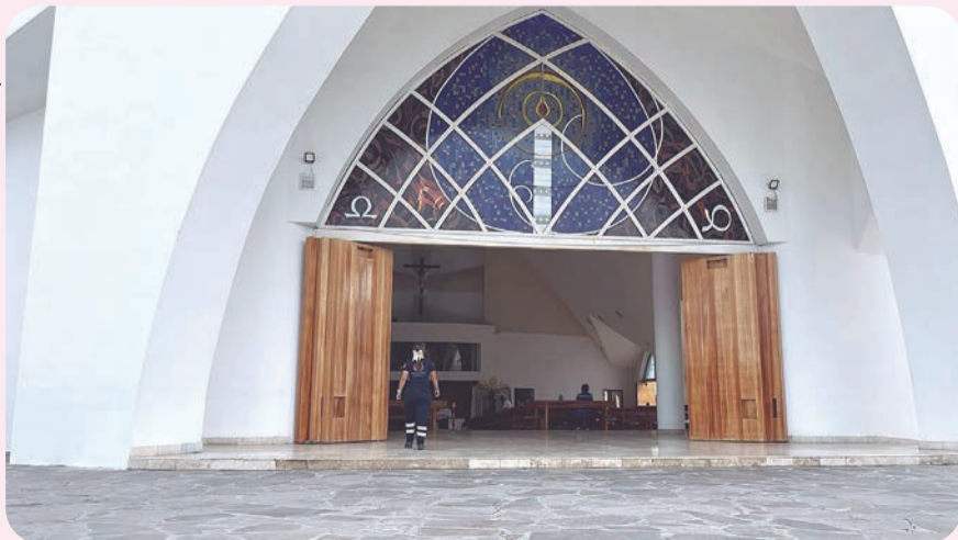
Integrantes del sindicato realizaron trabajos de pintura y mantenimiento en la herrería del templo previo a las fiestas patronales.
